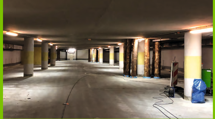
BA 1 - 1. UG während der Sanierungsmaßnahme, Notabstützung mit Stützen
